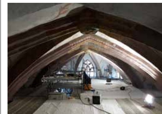
Arbeitsplattform im Chor
